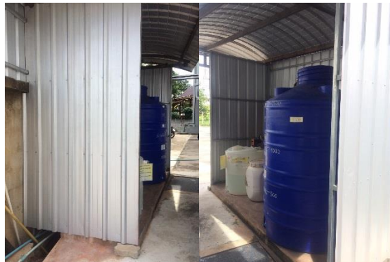
ภาพแสดง ถังเติมคลอรีนของระบบบำบัดน้ำเสียขั้นต้นของอาคาร โครงการและการเก็บตัวอย่างน้ำ
